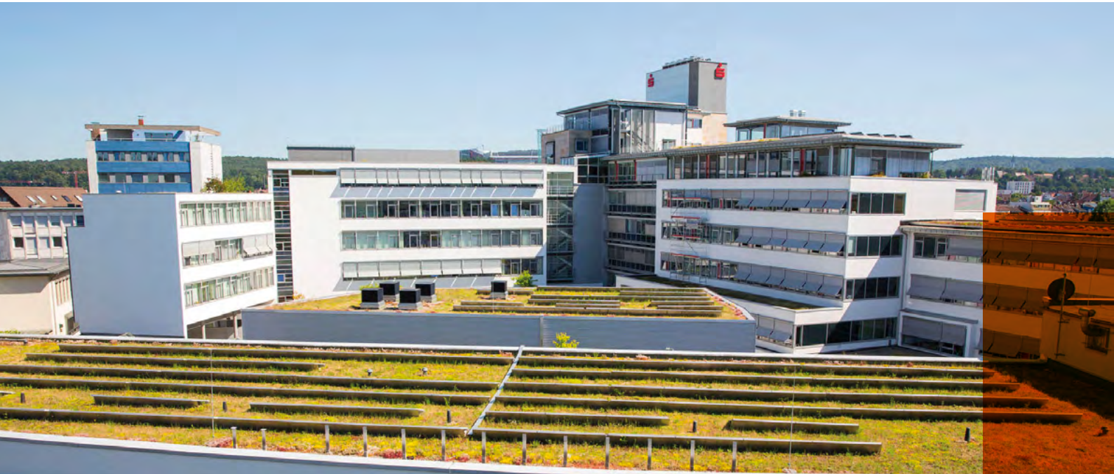
Auf dem Dach Solaranlagen und Begrünung – seit der Sanierung setzte die Kreissparkasse baulich auf Nachhaltigkeit.
